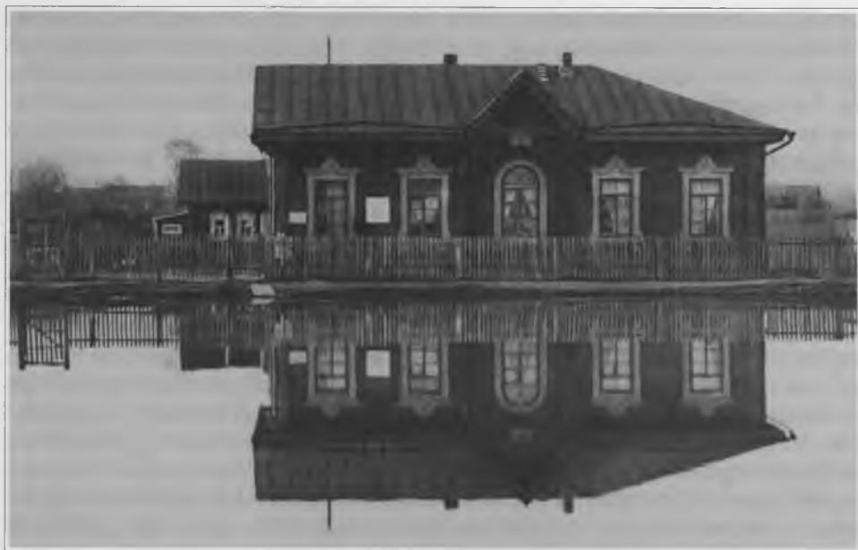
Здание школы с. Икково. На левом крыле установлены памятные доски. Одна из них сообщает: «Здесь в 1887 году И.Я. Яковлевым было открыто одноклассное училище». Фото ок. 1970 г.
