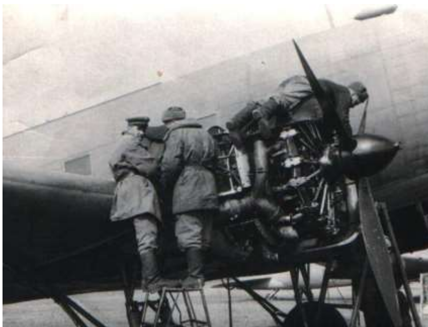
9-й перегоночный полк. Ремонтные работы. ок. 1945 г.
