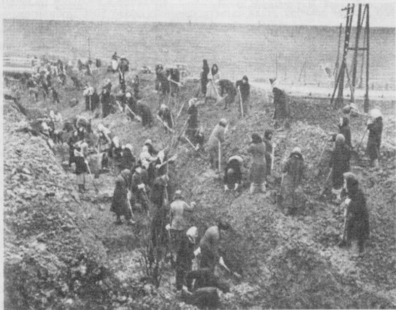
На строительстве оборонительных сооружений (Фото 1941 г.)
