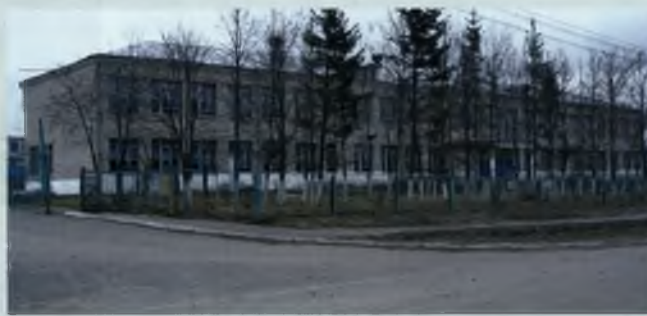
Кирпичное здание школы возведено в 1972 году.
