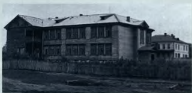
Двухэтажное здание школы построено в конце 1941 года.
