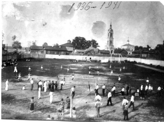
На строительстве катка на ул. Луговая, 1936 год
