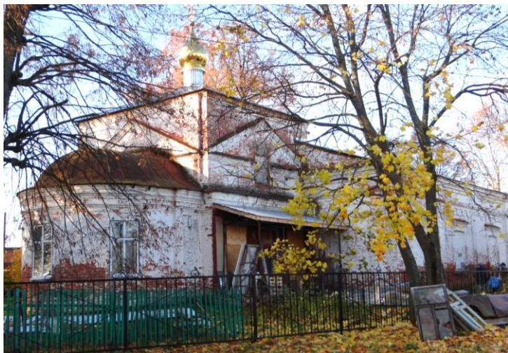
В храме идут ремонтно-восстановительные работы. 2013 г.
