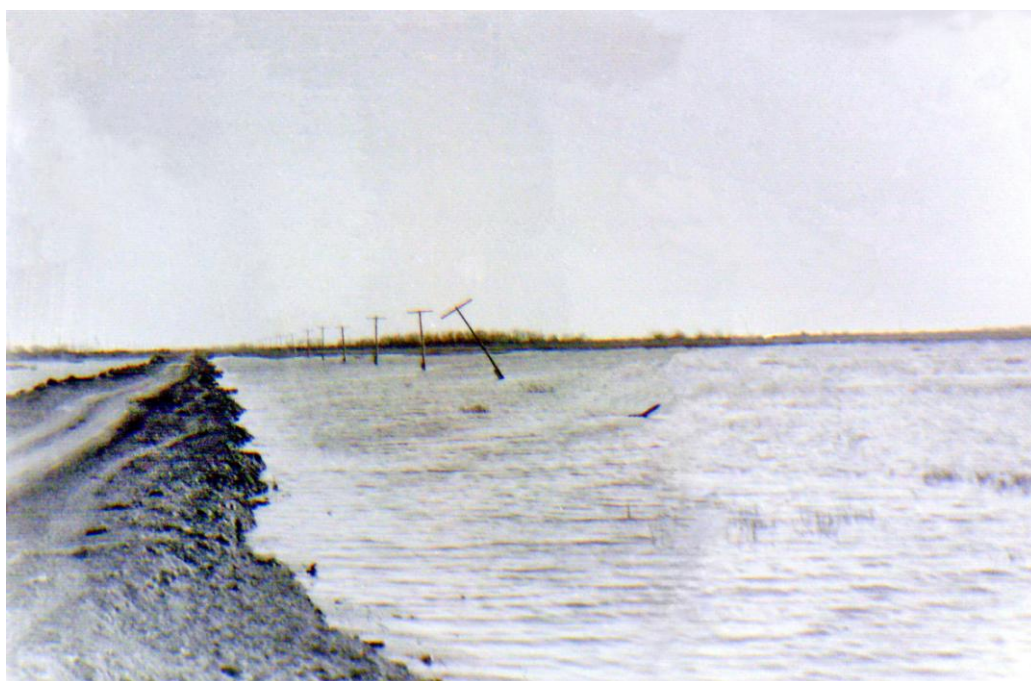
Дорога в Пешной. Дамба местами подтоплена.
