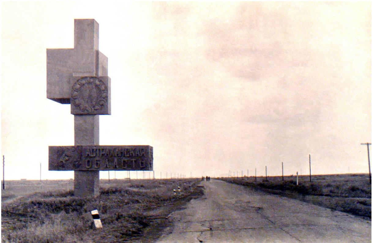
Железобетонно... Вид на юг.
