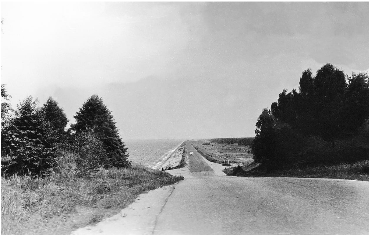
Небольшой подъем после ГЭС. Красивый вид привлекателен для фотографа.
