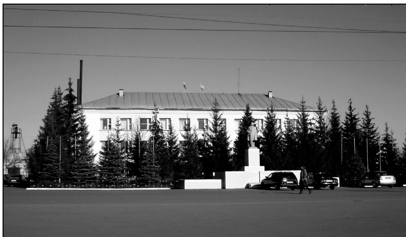
Здание администрации Вурнарского муниципального района Чувашской Республики. Август 2008 года.
