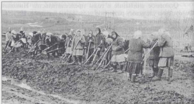
Колхозники 1 бригады на строительстве мощной дороги в д. Большие Яныши. 1963 г.
