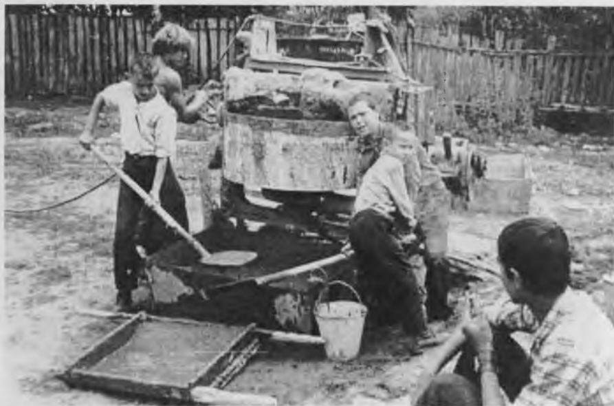
Растворо-бетонный узел, 1983 г
