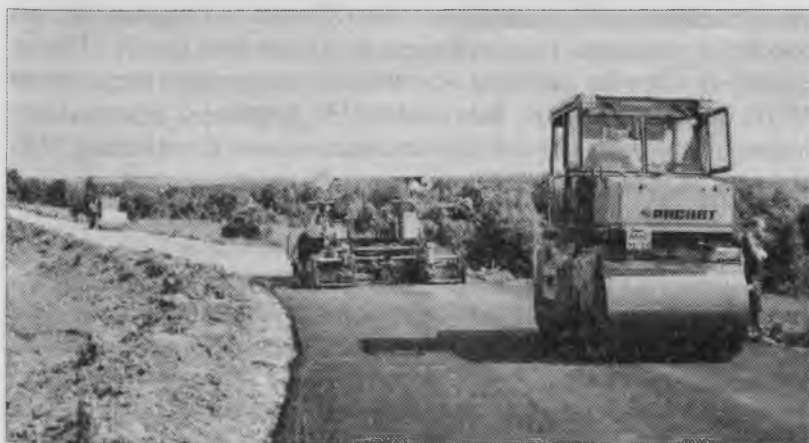
Прокладка асфальтовой дороги в деревню Юрьевка. 2007 год На снимке: Каткист Юрий Григорьев в кабине, рабочий Евгений Коротков
