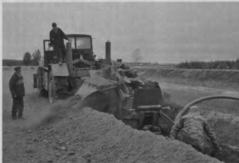
Прокладка газопровода. 2000-е гг.
