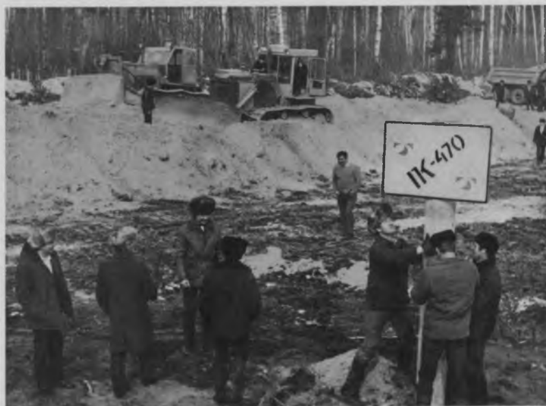
Строительство автодороги Ибреси — Буинск. Начало 1980-х гг.
