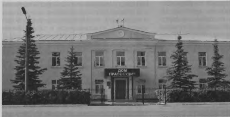
Здание районного суда. пос. Ибresi.
