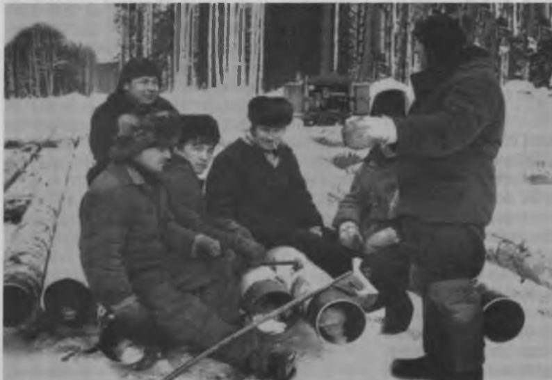
Строительномонтажные работы на линии газопровода.
