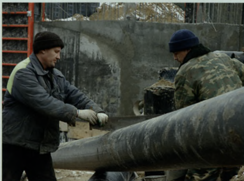
Строительство водовода. пос. Буинск. 2008.
