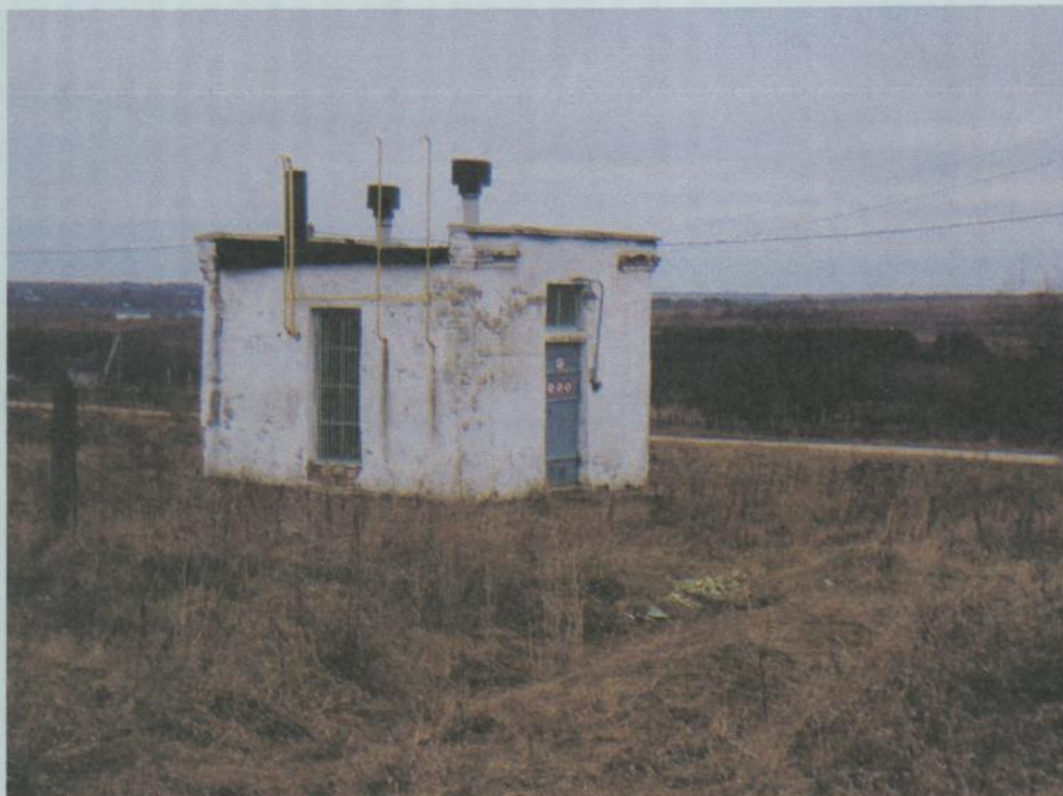
Газораспределительный пункт расположен в торце Тури орам с восточной стороны. Газ начал поступать в первые дома осенью 1990 года.
