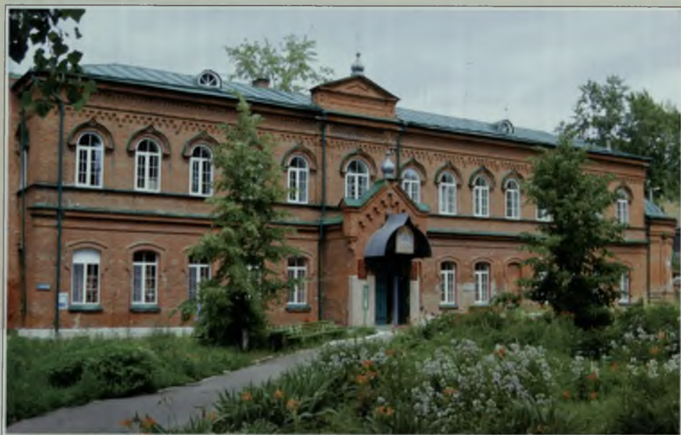
Учебный корпус, в котором располагалась домовая церковь Симбирской чувашской учительской школы. Фото 1998 г.
