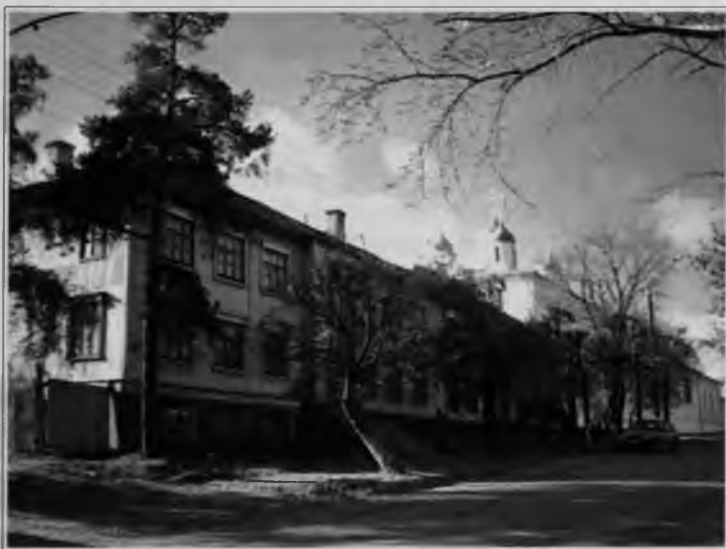
Дом, в котором жил С.М. Максимов. Квартира располагалась на втором этаже в правой части здания. 2002 г.
