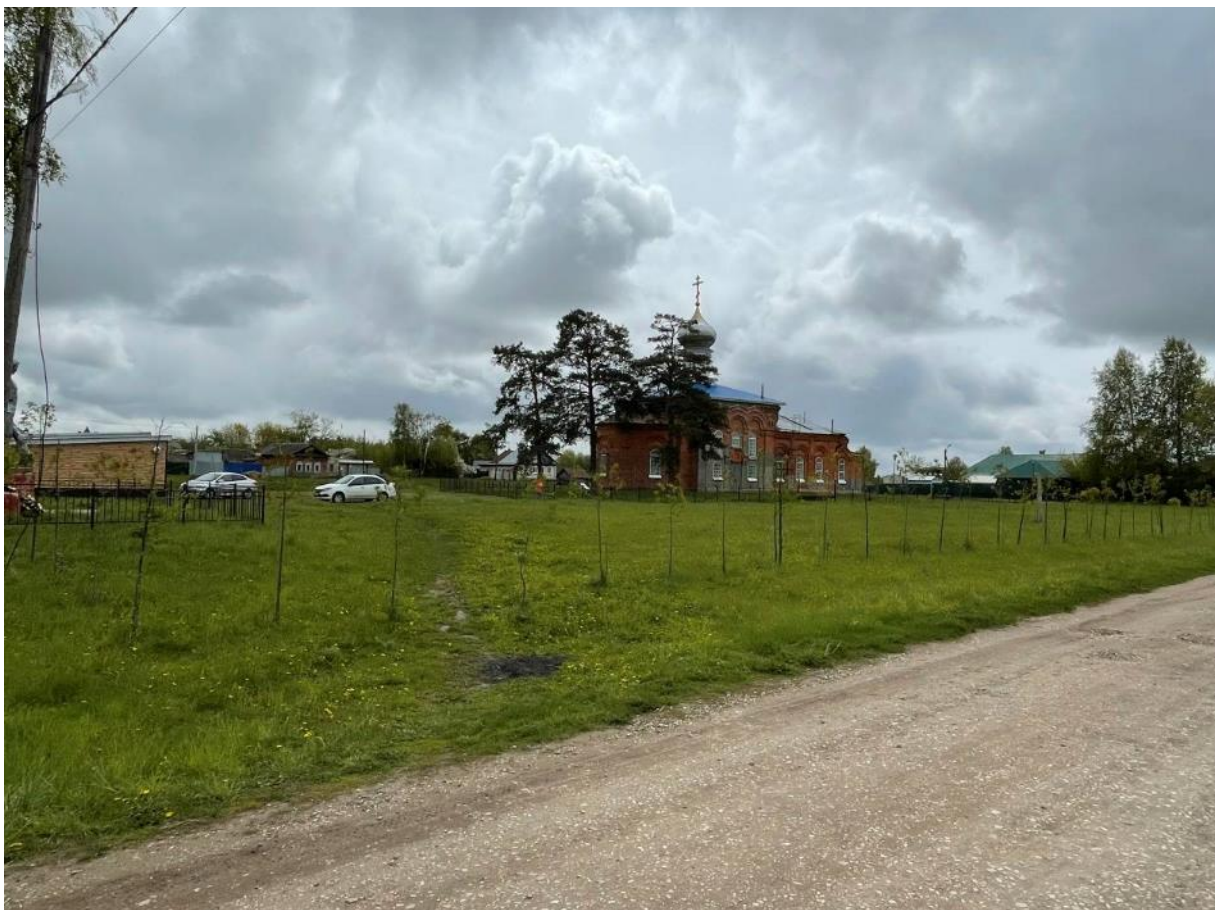
Фото 26 Общий вид исследуемого ОКН с севера, с ул. Тенистой
