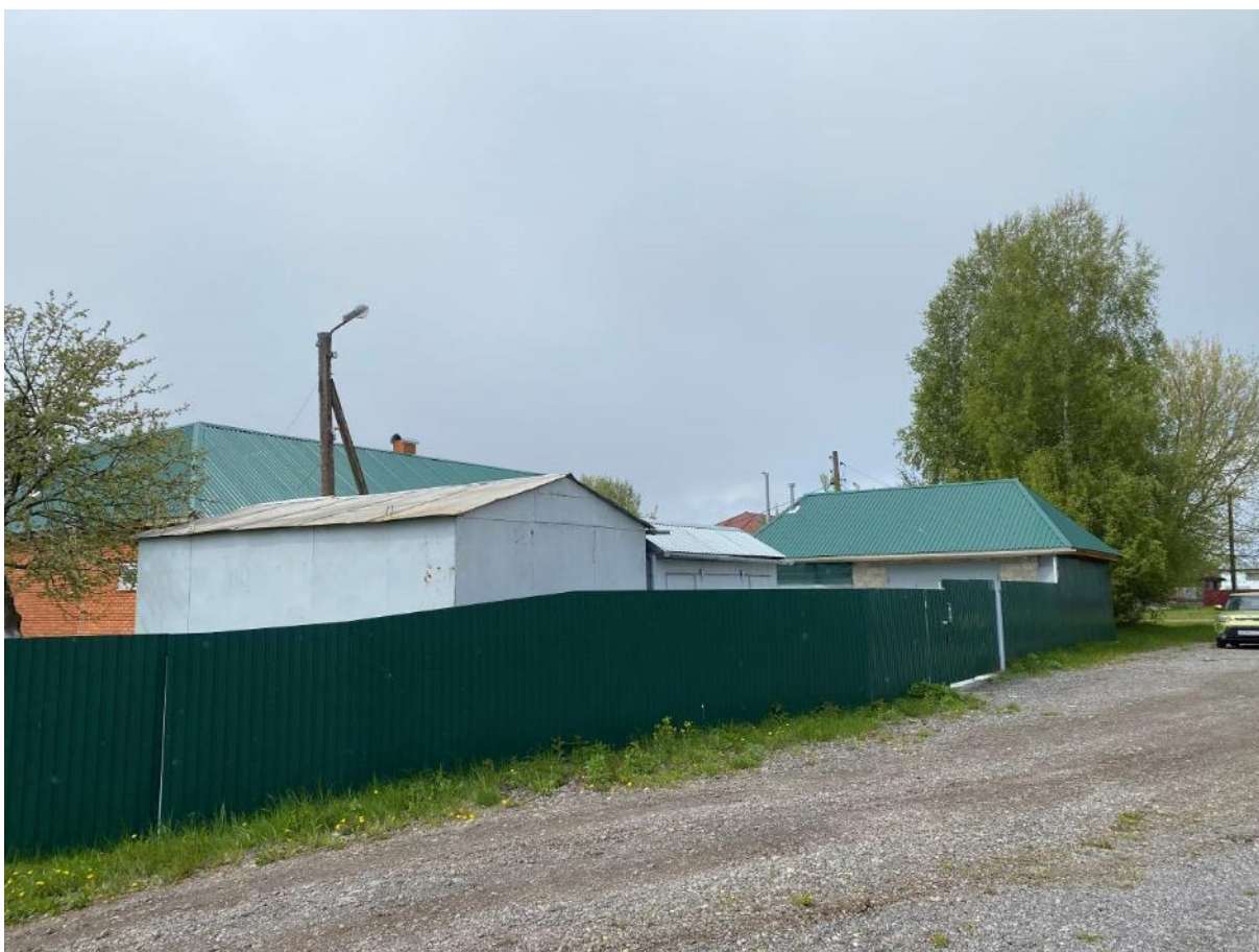
Фото 14 Вид на диссонирующее ограждение северной границы домовладения по адресу ул. Солнечная, 20
