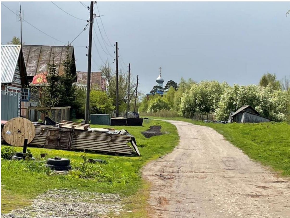
Фото 7 Дальний вид исследуемого ОКН с северо-востока, с ул. Тенистой, в районе домовладений под №№ 40-41
