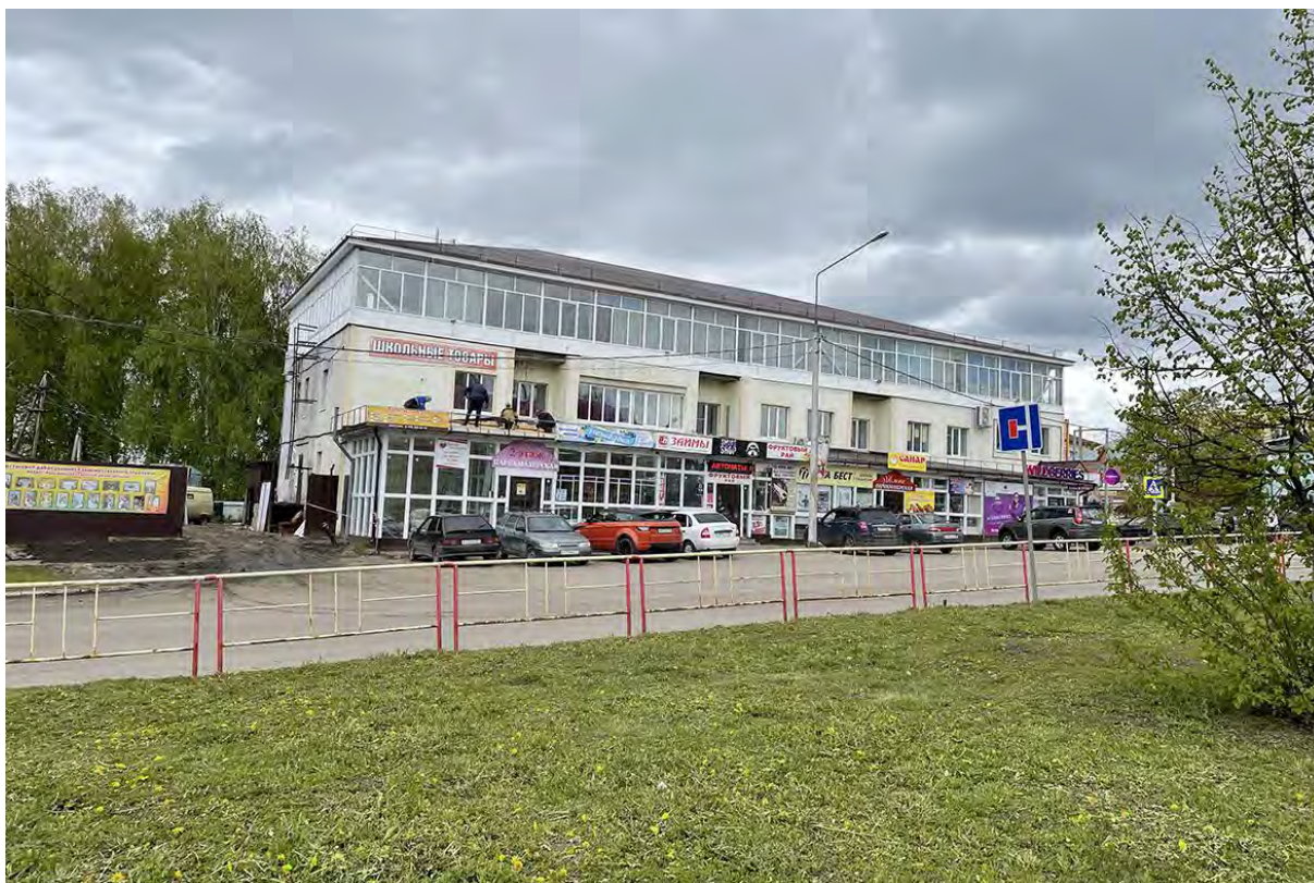
Фото 3 Застройка нечетной стороны ул. Канаишской к юго-востоку от ОКН «Памятник коммунистам и советским активистам, погибшим во время кулацкого мятежа 1921 году», торговый дом (ул. Канаишская, 33)
