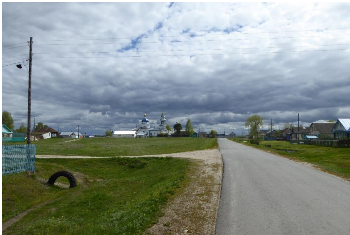
Фото 7 Общий вид исследуемого ОКН с севера, с ул. Речной, в районе домовладения под № 33
