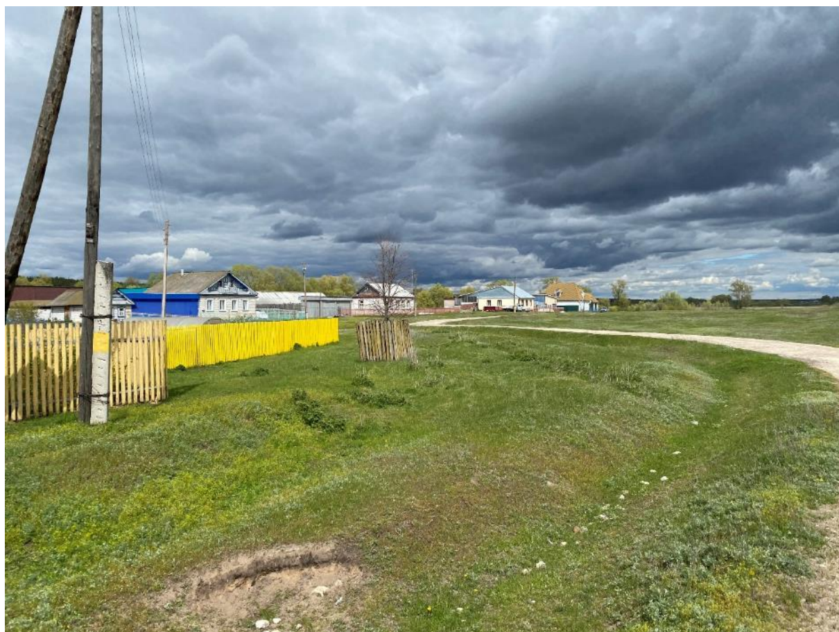
Фото 10 Вид на застройку ул. Речной с запада. Домовладения под №№ 25 – 17
