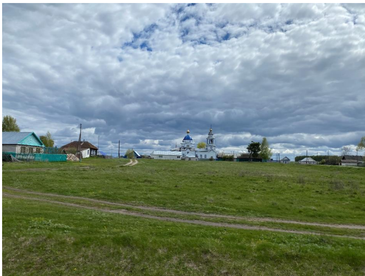
Фото 8 Общий вид исследуемого ОКН с севера, с ул. Речной, в районе домовладения под № 31
