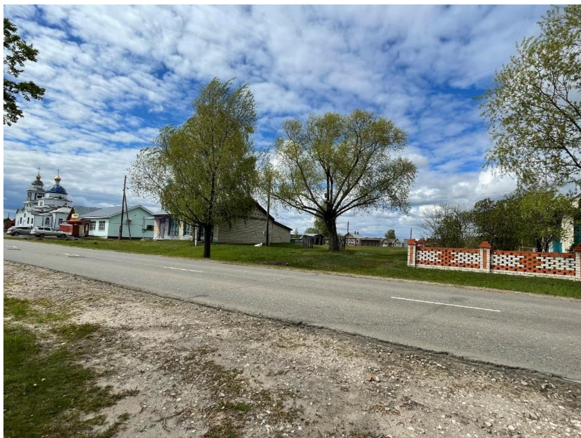
Фото 16 Перспективный вид четной стороны застройки ул. Антонова в направлении исследуемого ОКН в районе домовладений под №№
