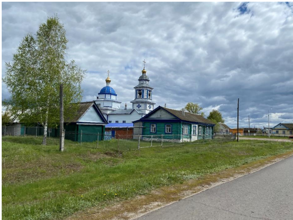
Фото 20 Общий вид исследуемого ОКН с северо-запада
