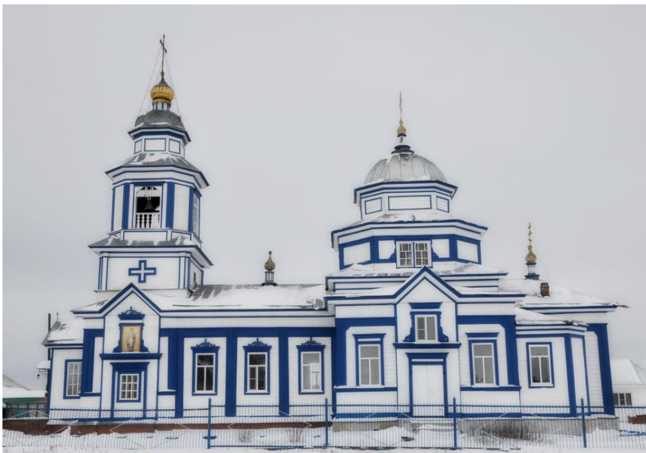
Вид ОКН с юга. Фасад по ул. Антонова
