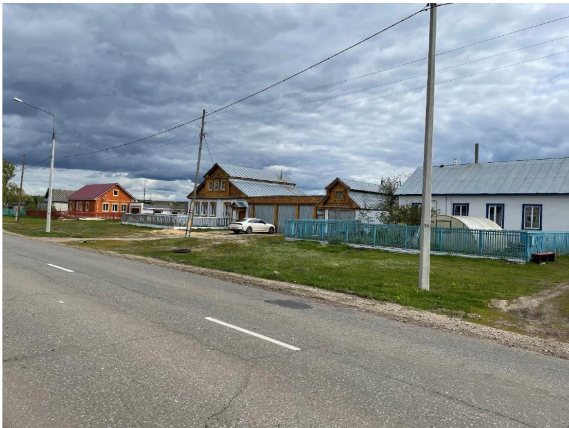
Фото 17 Перспектива нечетной стороны застройки ул. Антонова в восточном направлении. Общий вид на объект, адаптированный к характеристикам историко-градостроительной среды – современное домовладение по адресу ул. Антонова, 27
