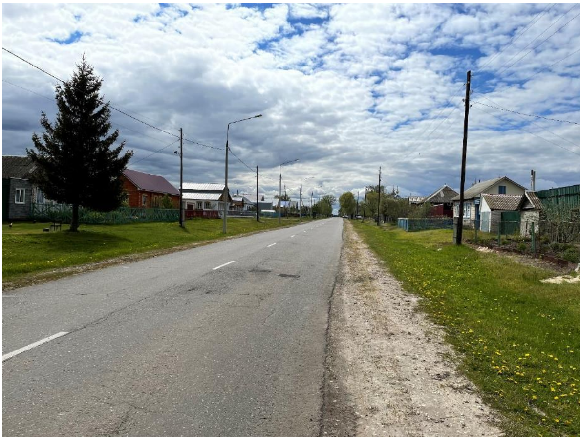
Фото 15 перспектива ул. Антонова в западном направлении в районе домовладений под №№ 29-31
