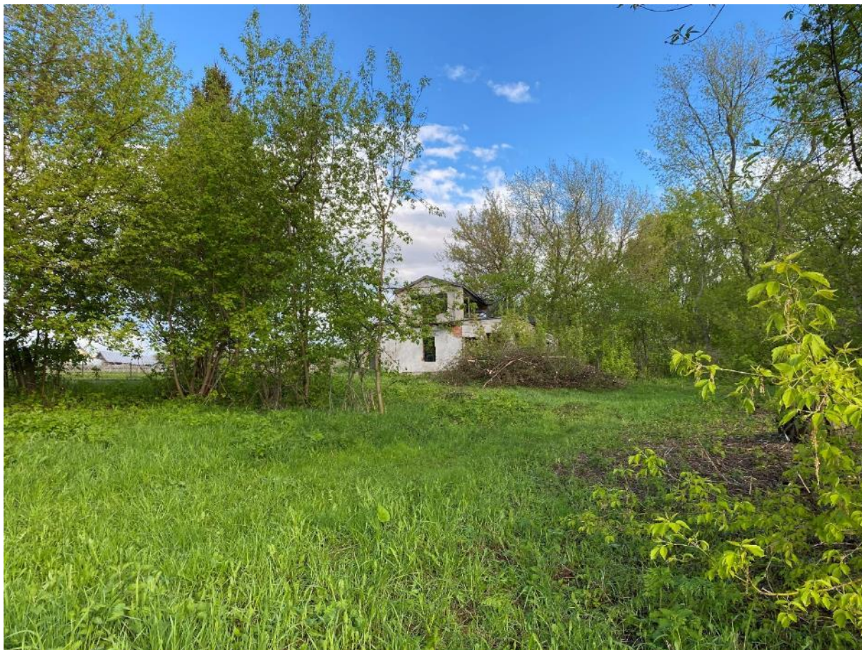
Фото 11 ОКН «Дом, в котором жили чувашские писатели Ухсай Я.Г. и Ухсай М.Д.». Вид с северо-востока от оврага
