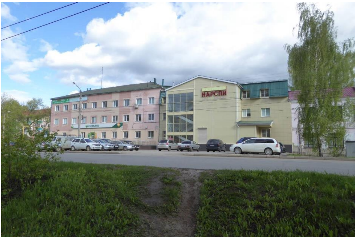
Фото 12 Вид на пристроенные к исследуемому ОКН с запада поздние здания с противоположной стороны ул. Пушкина
