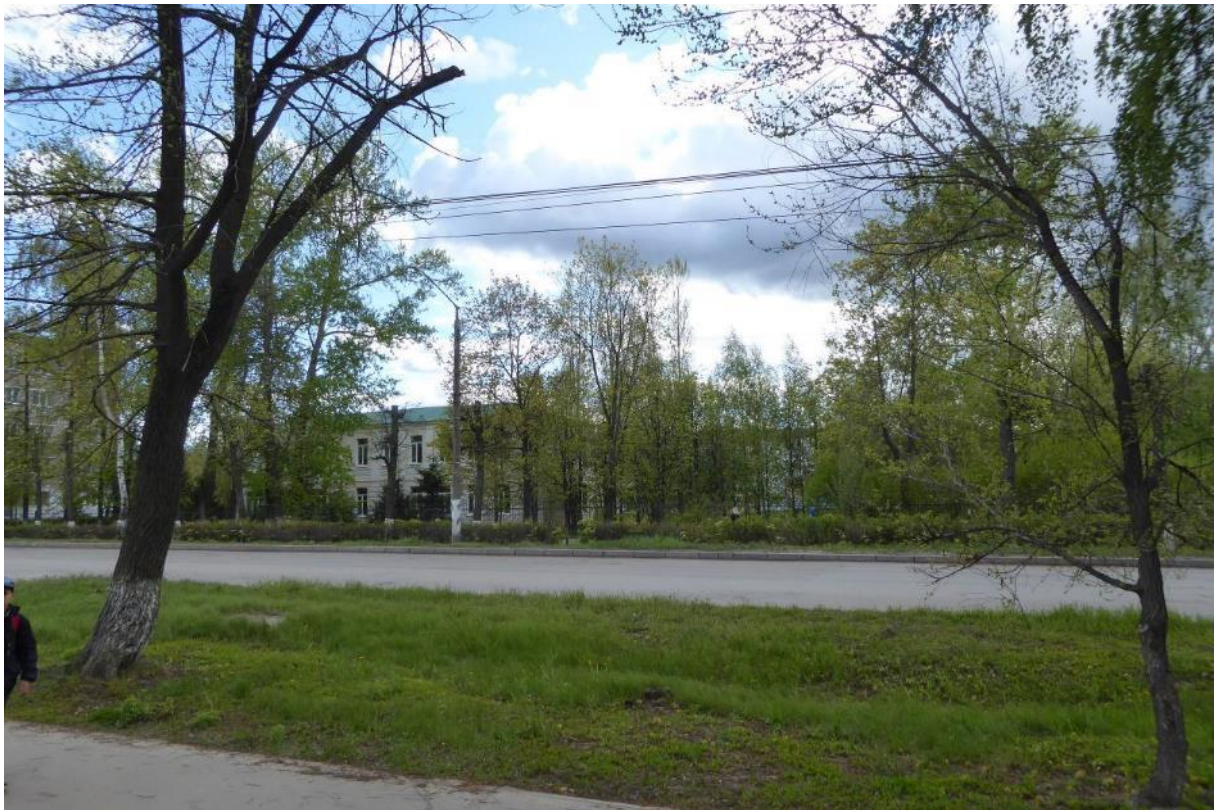
Фото 3 Общий вид ценного объекта историко-градостроительной среды – корпуса педколледжа, ул. 30 лет Победы, 22
