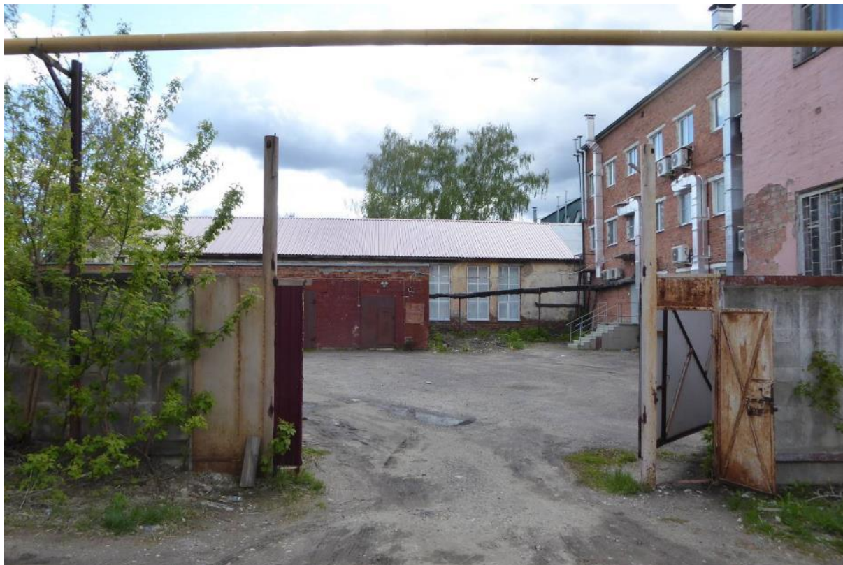
Фото 15 Вид на дворовой фасад исследуемого ОКН с востока
