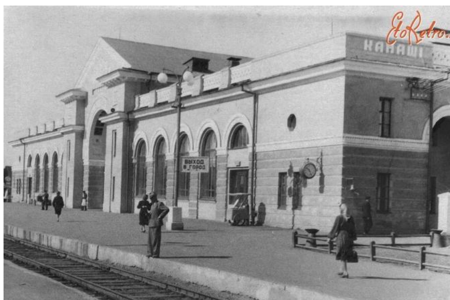
Рис. 7. Общий юго-западный вид здания вокзала с перрона, 1955 г.
