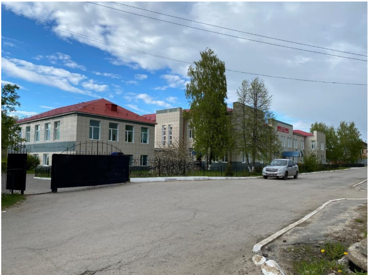
Фото 10 Общий вид исследуемого ОКН с юго-запада, с проезжей части ул. Павлова
