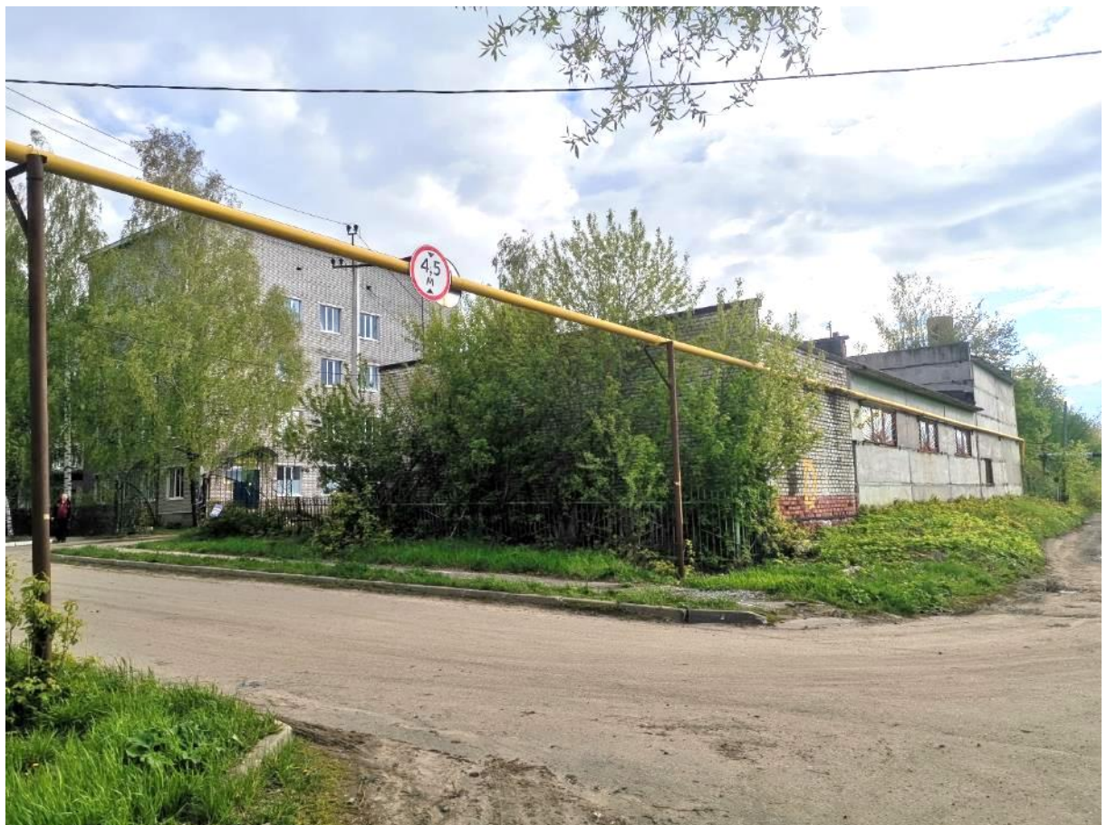
Фото 20 Общий вид на постройки больницы с пересечения улицы Филатова и переулка Шихраны, с северо-востока
