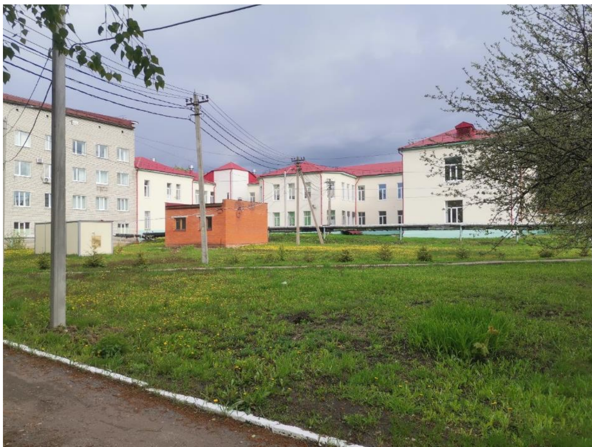
Фото 16 Общий вид на исследуемый ОКН из сквера на территории больницы с северо-запада
