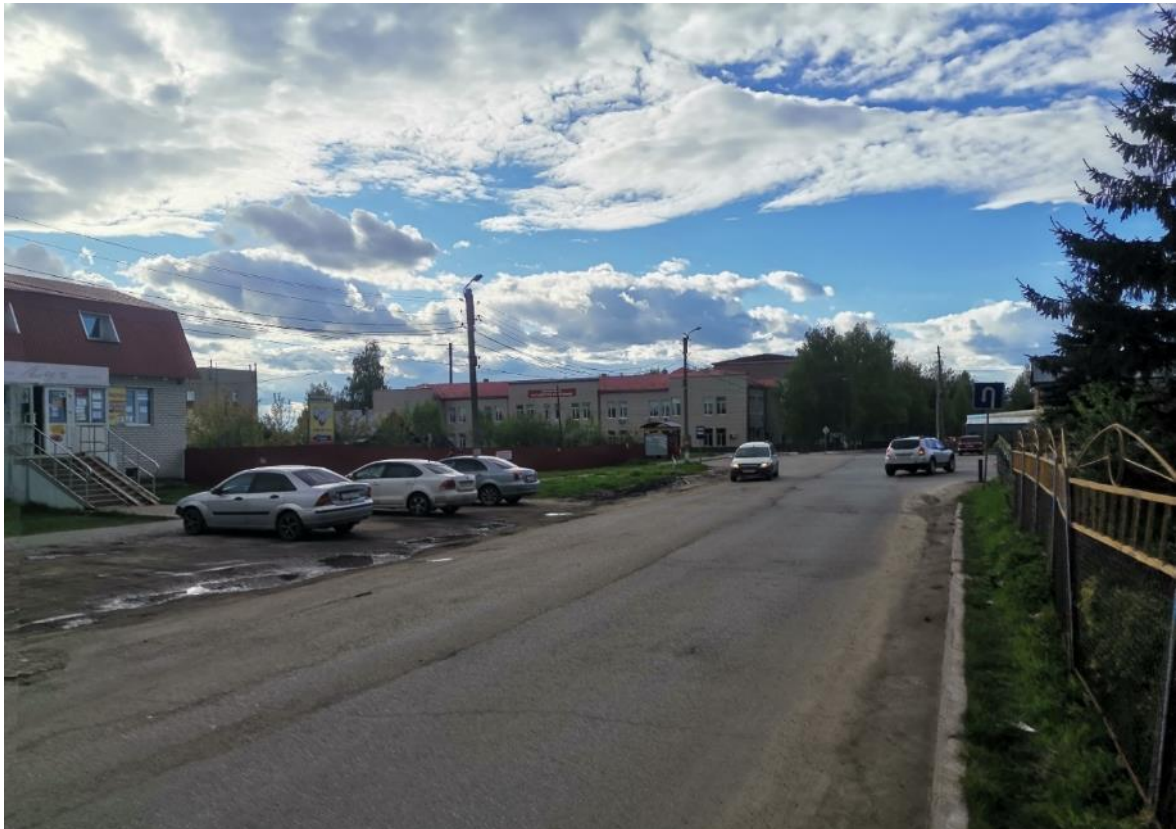
Фото 1 Дальний вид исследуемого ОКН «Дом, в котором в годы Великой Отечественной войны размещался эвакуогоспиталь», 1941-1945 гг., с юго-востока, с ул. Филатова
