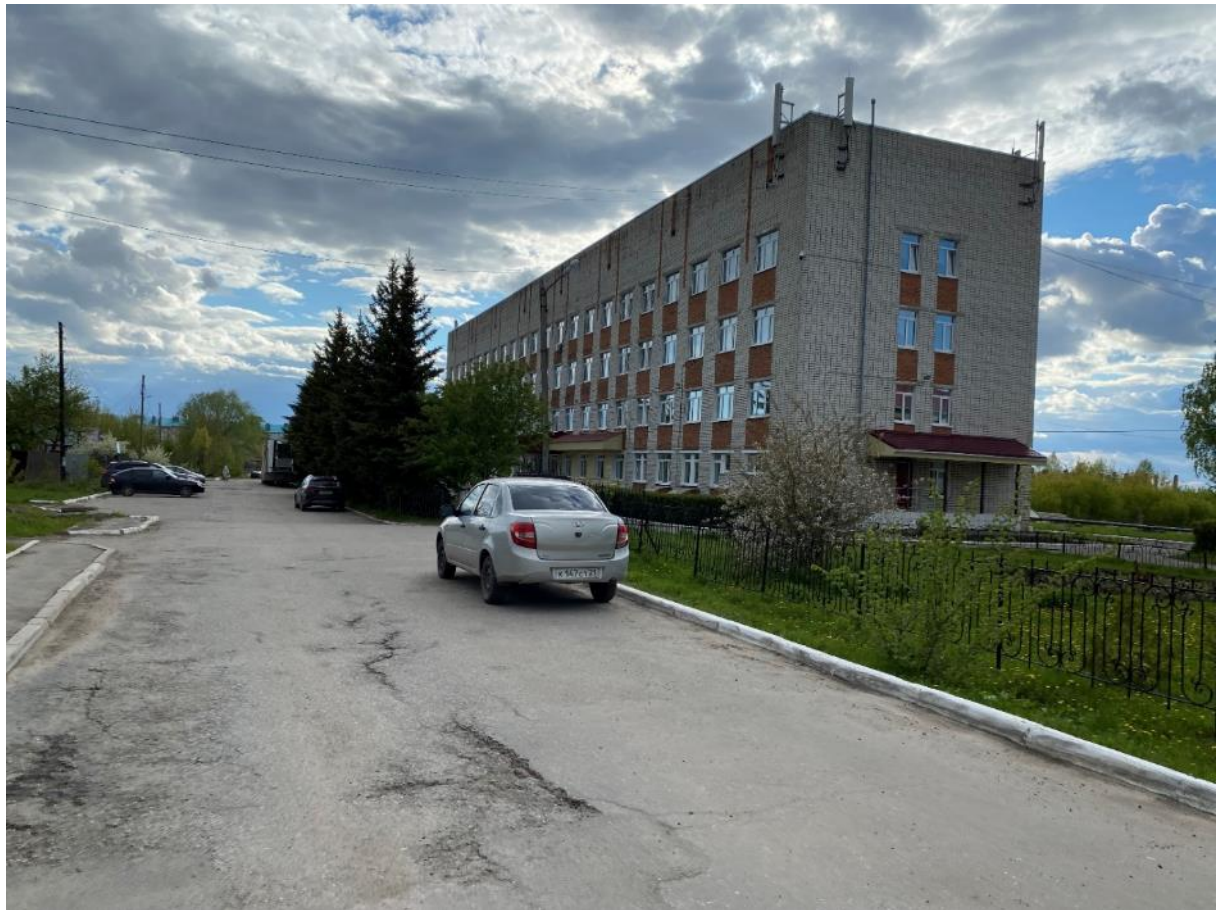
Фото 7 Общий вид здания поликлиники, 1980-х гг., с юго-востока, с ул. Павлова
