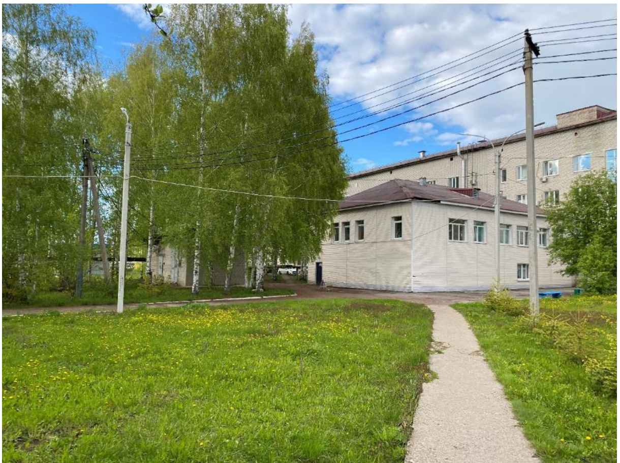
Фото 14 Вид на четырехэтажный корпус больницы с юго-востока, из сквера на территории больницы
