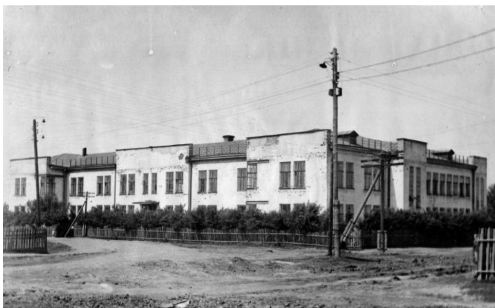
Рис. 12. Общий вид здания, фото второй половины XX в.
