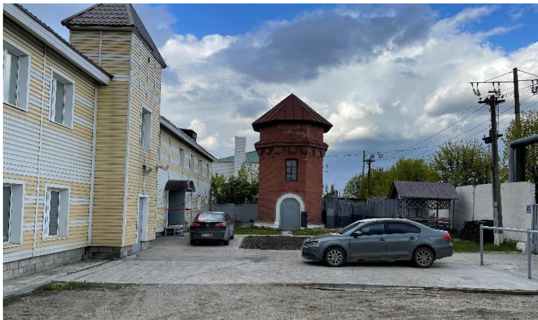
Общий вид объекта культурного наследия «Водонапорная башня «Канаш западный», вид с запада. Фото из проектной документации
