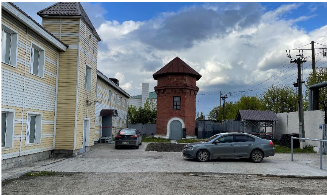
Общий вид исследуемого ОКН с запада
