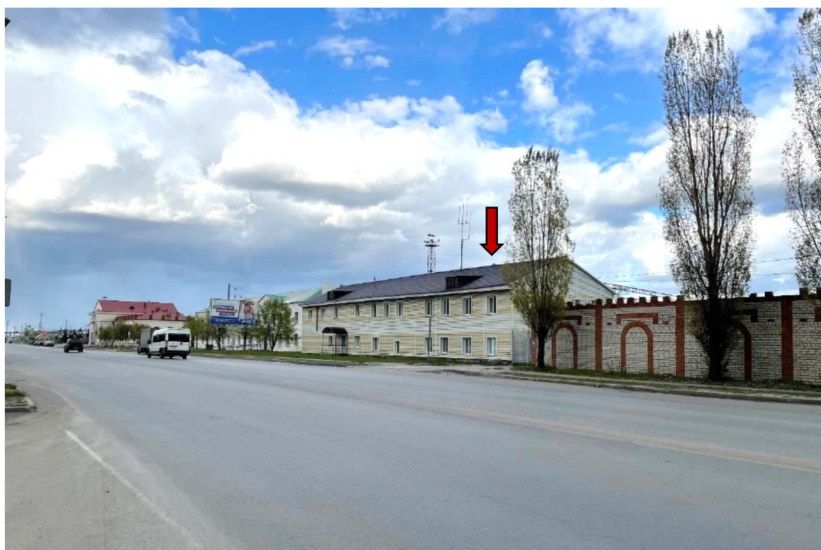
Фото 6 Перспектива нечетной стороны застройки ул. Железнодорожной в направлении исследуемого ОКН от дома под № 63
