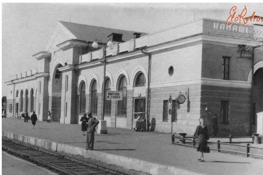
Рис. 6. Общий юго-западный вид здания вокзала с перрона, 1955 г.
