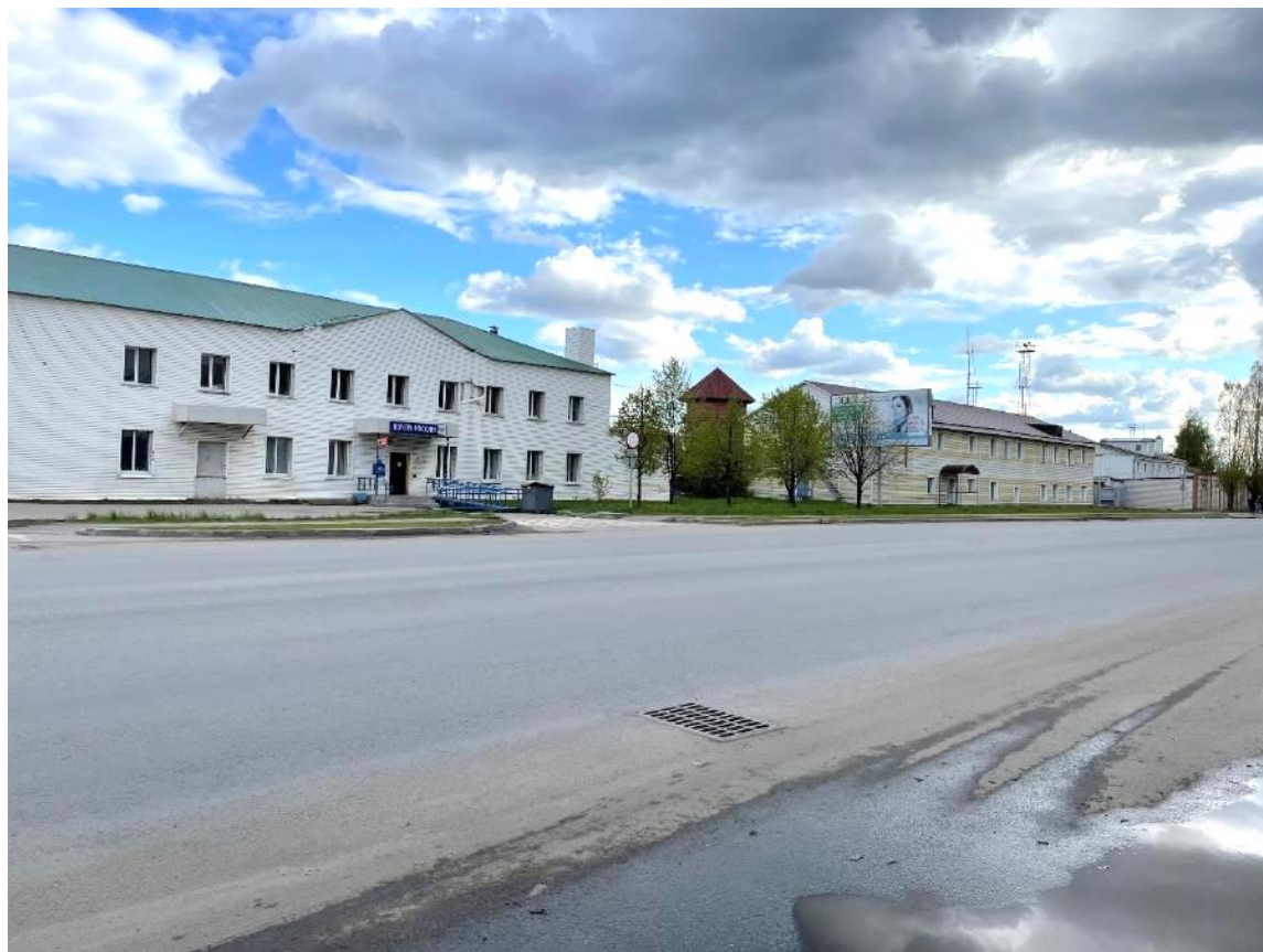
Фото 2 Общий вид исследуемого ОКН с проезжей части ул. Железнодорожной, с северо-востока
