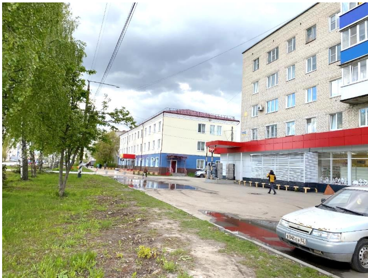
Фото 3 Перспектива нечетной стороны застройки ул. Железнодорожной в восточном направлении в районе дома под № 67
