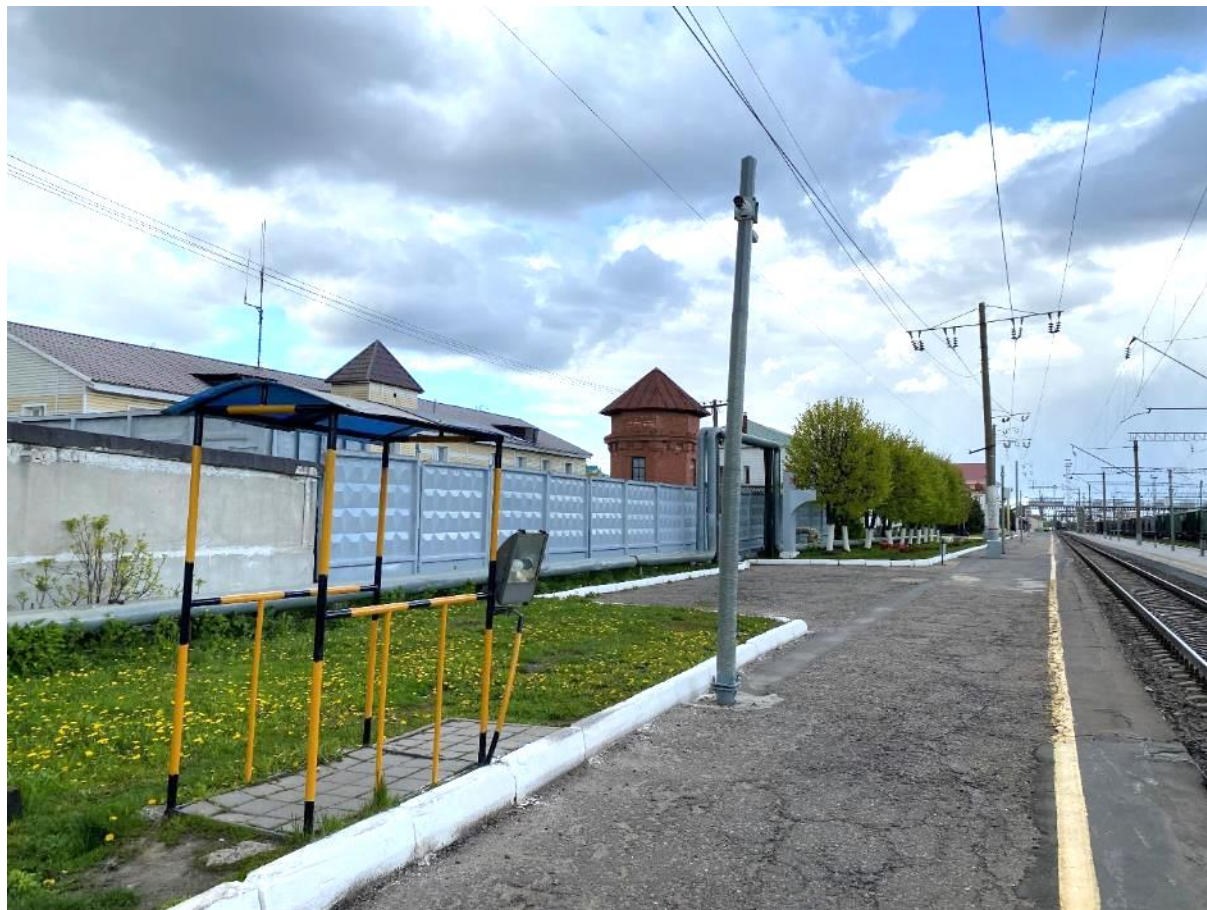
Фото 9 Общий вид исследуемого ОКН с перрона, в северо-восточном направлении
