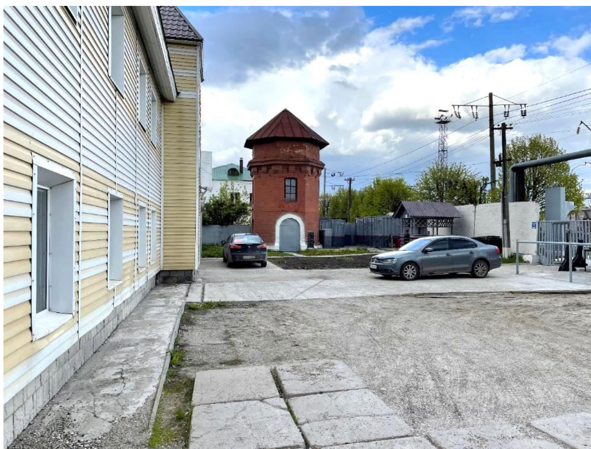
Фото 10 Общий вид исследуемого ОКН от противоположной границы участка
