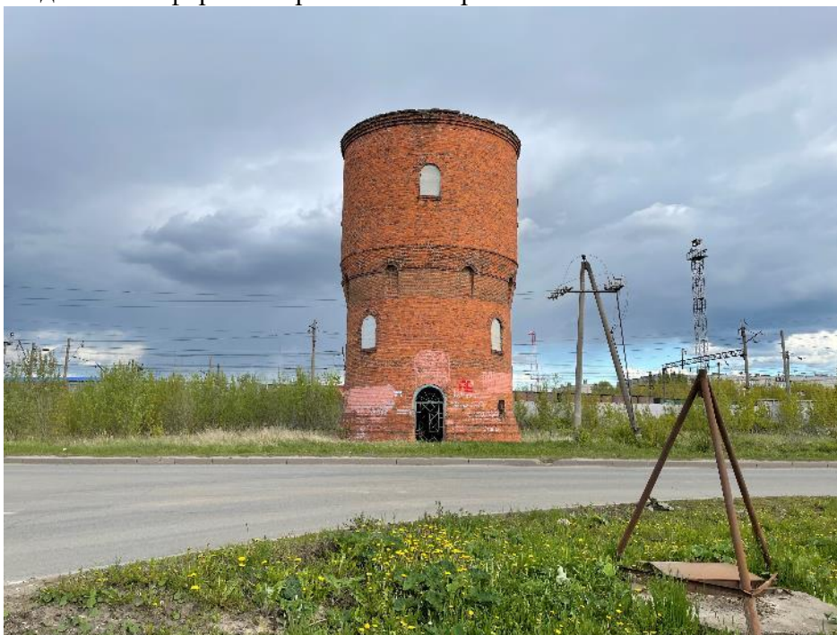
Общий вид объекта культурного наследия «Водонапорная башня «Канаш восточный», вид с севера. Фото из проектной документации
