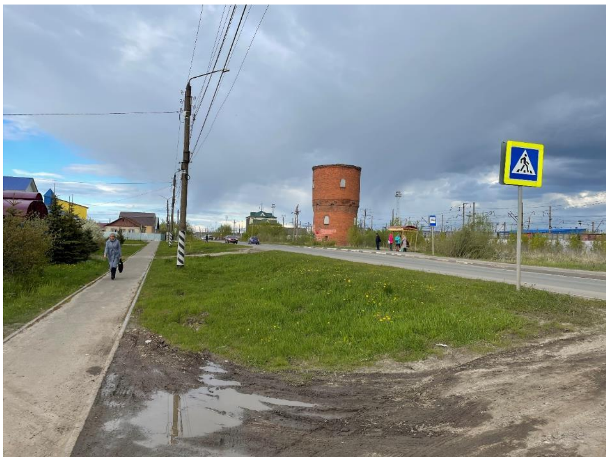
Фото 6 Общий вид исследуемого ОКН с противоположной стороны ул. Железнодорожной с запада
