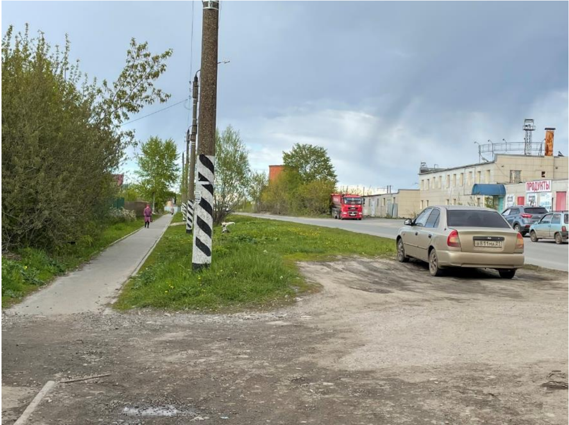
Фото 1 Дальний вид исследуемого ОКН «Водонапорная башня "Канаш восточный"», 1925 г., в створе ул. Железнодорожной с запада
