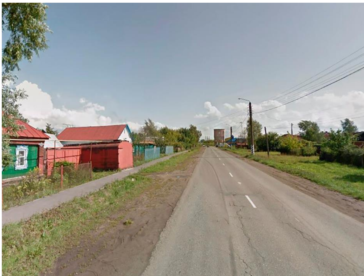
Фото 14 Дальний вид исследуемого ОКН в створе ул. Шихраны с пересечения с ул. Туренева
