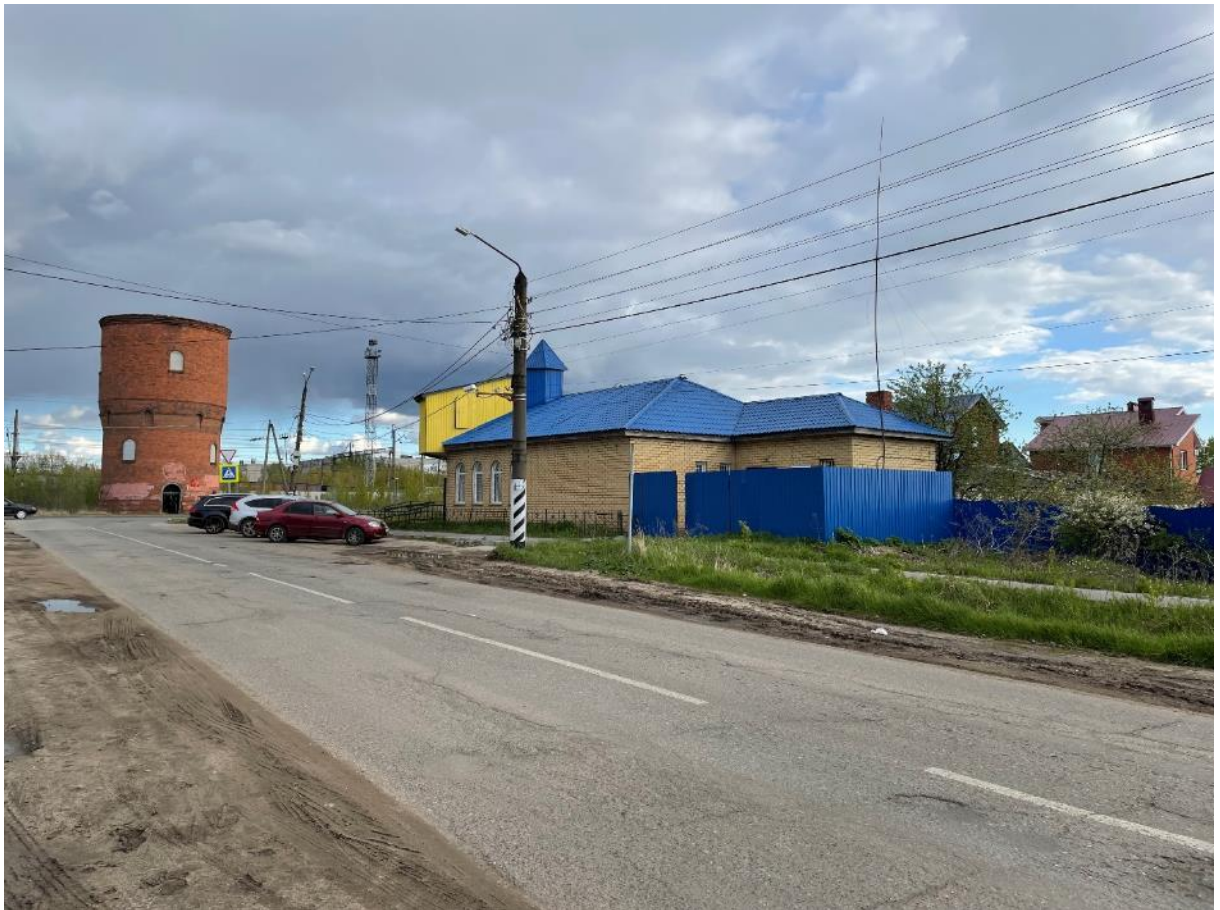
Фото 11 Вид на нечетную сторону застройки ул. Шихраны и общий вид исследуемого ОКН с северо-востока, от домовладения по адресу ул. Шихраны, 16
