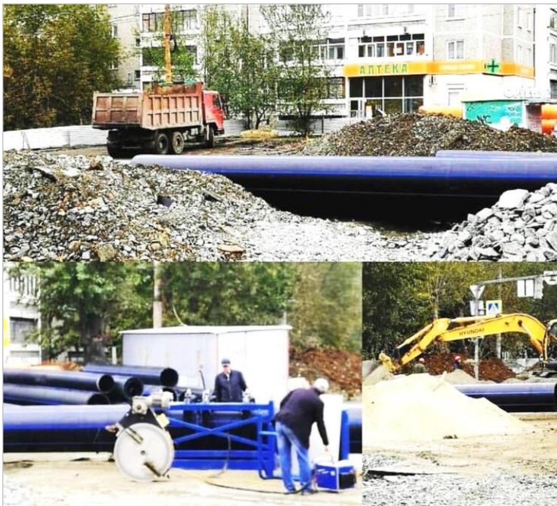
На снимке: В центре города Екатеринбурга прокладывают трубы производства завода ООО «ТрубМирПласт».
