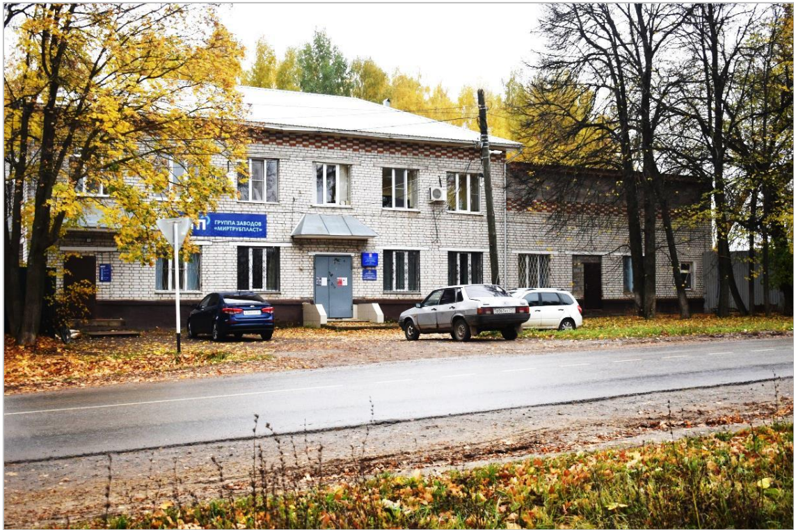
На снимке: Административное здание Большесундырского завода полиэтиленовых труб. 2022 г.
