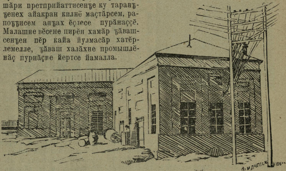
[Шупашкар хулинѳѣ Комунпайѣн 1921 ѳ. тунѣ електритсѣ стансийѣ.
