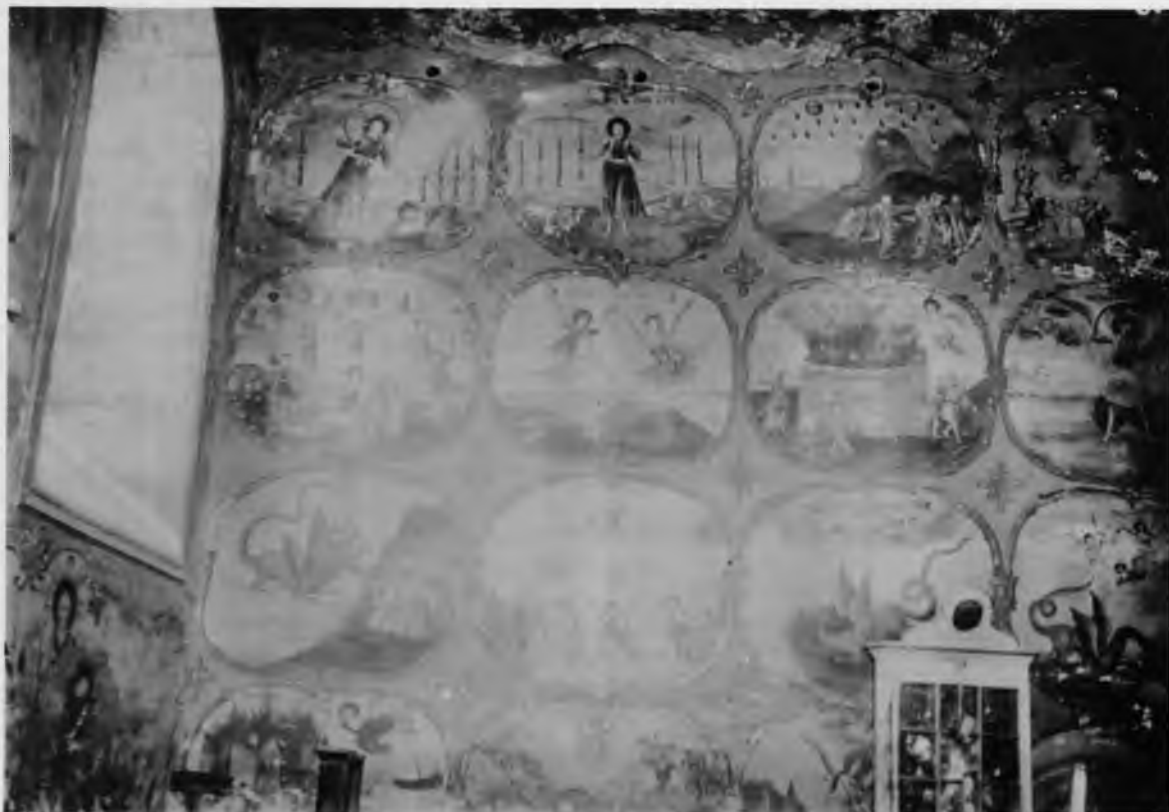
Роспись северной стены Владимирского храма. Фото М.М. Бе- ляева. 1930 г. ЧГХМ
